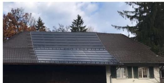
3 Vollflächige Solarmodule mit integrierten Dachflächenfenstern
