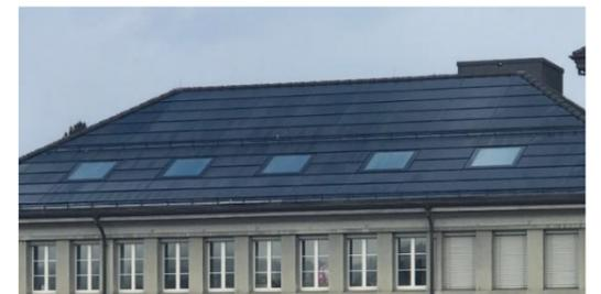
4 Vollflächig verwendete ziegelrote Solarmodule:
